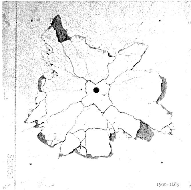
a. Crack pattern.
