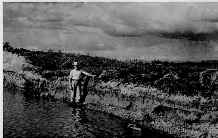
(d) Silt-filled channel
