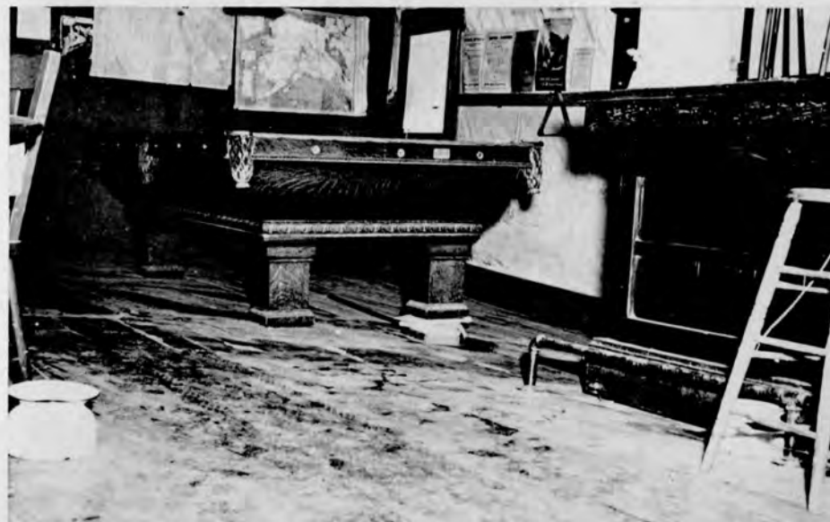
(d) Floor settlement, Livengood Pool Hall
