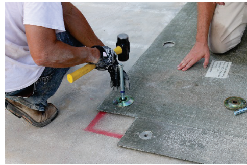
(d) Placing concrete anchor.
