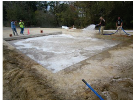
(d) Ensuring water coverage
