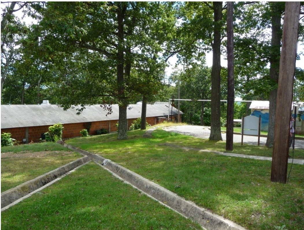
Figure 212. Drainage swales (ERDC-CERL, 2012).
