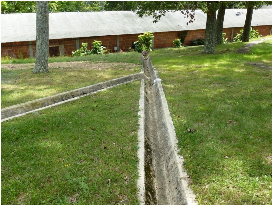
Figure 213. Drainage swales (ERDC-CERL, 2012).
