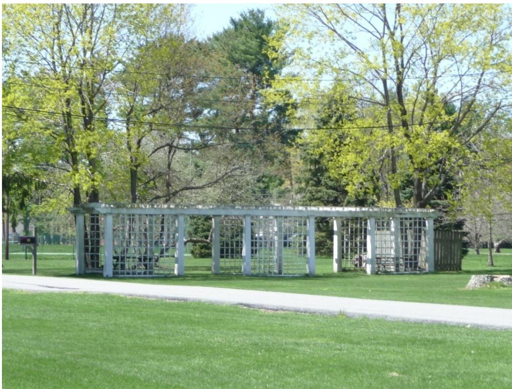
Figure 56. Building 113A (ERDC-CERL, 2013).
