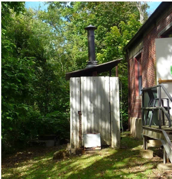
Building 171B – Incinerator (1969) (ERDC-CERL, 2012).
