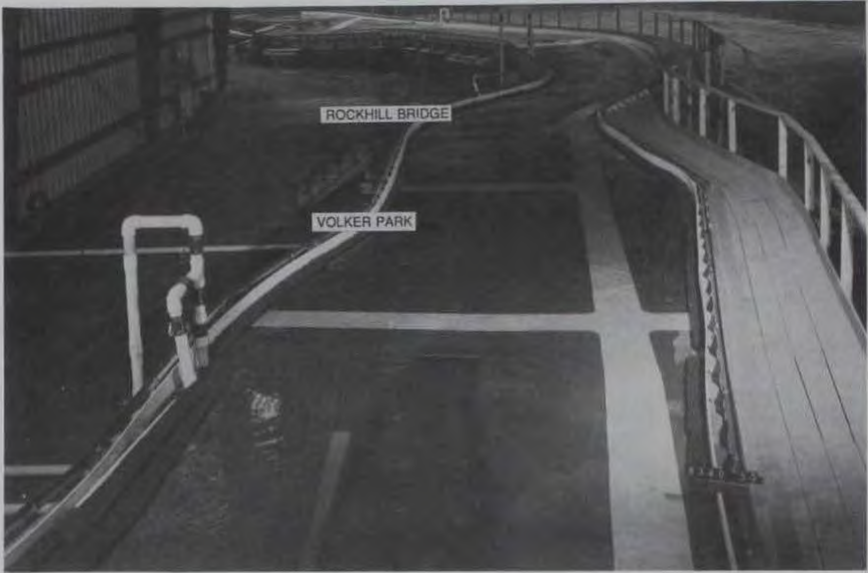
e. Sta 81+00 to sta 112+00
