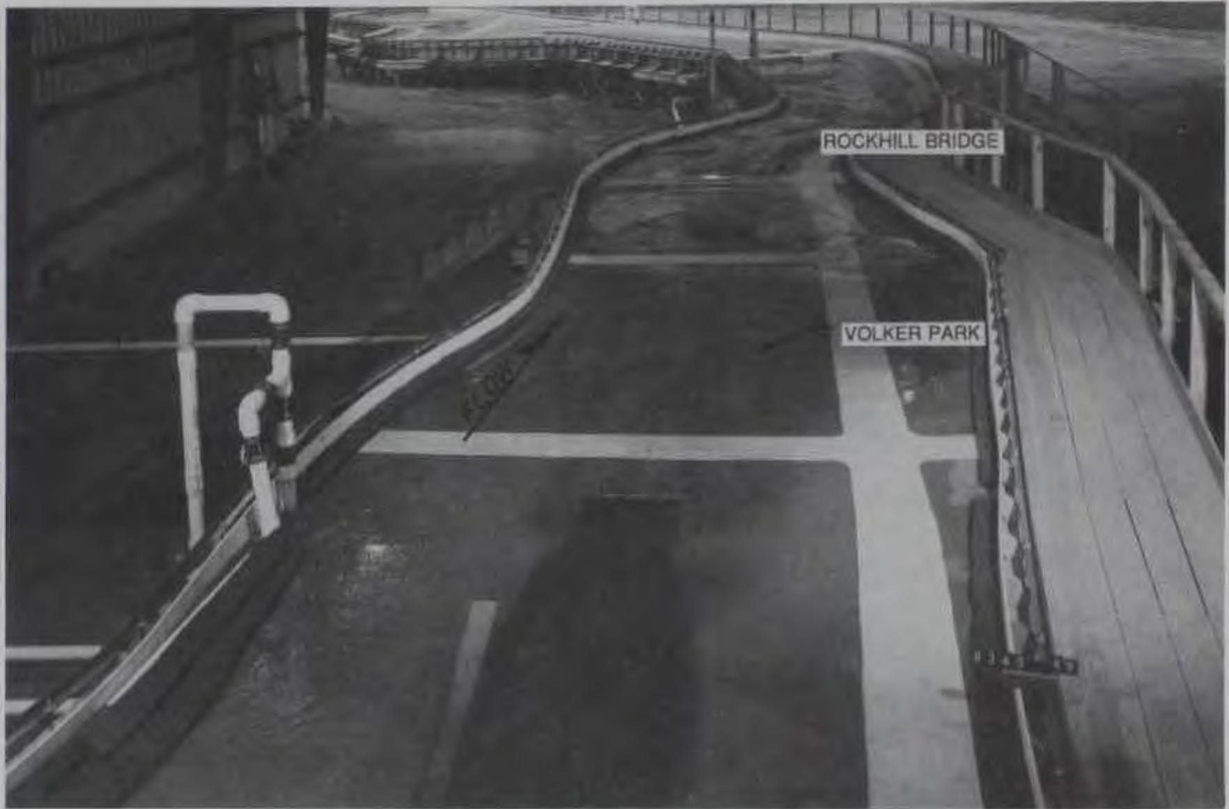
e. Sta 81+00 to sta 112+00
