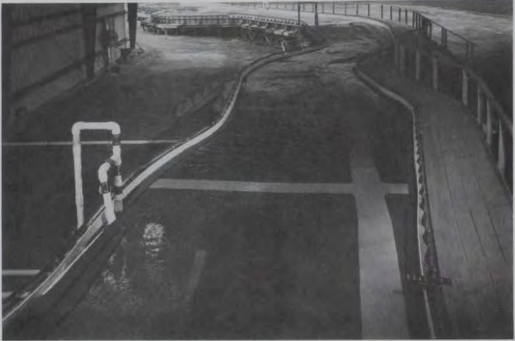
e. Sta 81+00 to sta 112+00
