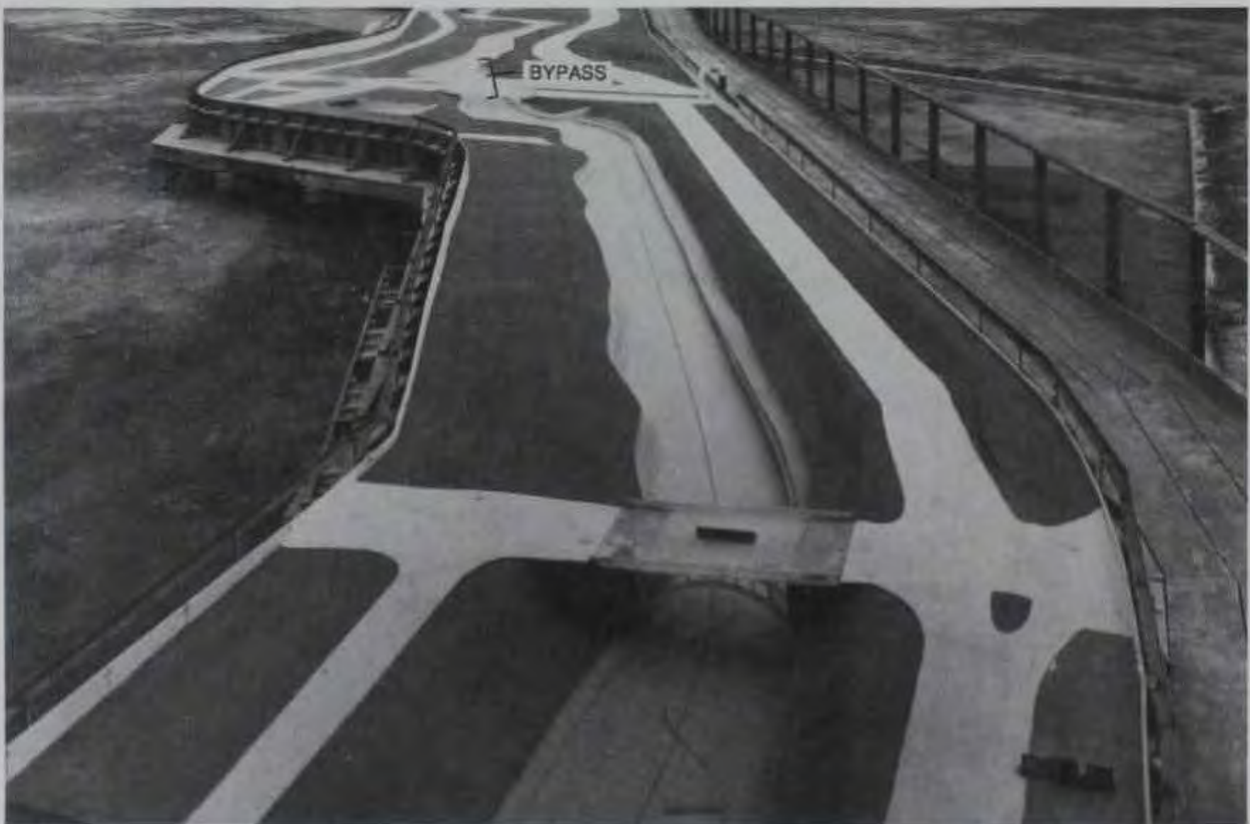
d. Sta 112+00 to sta 147+00
